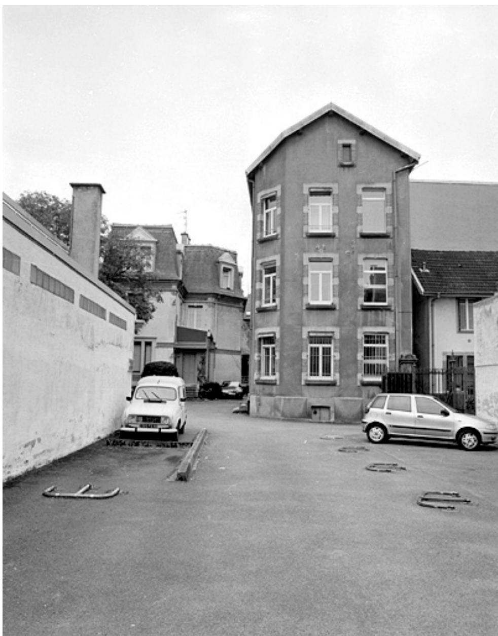
Logement patronal situé à l'arrière du n° 25.
