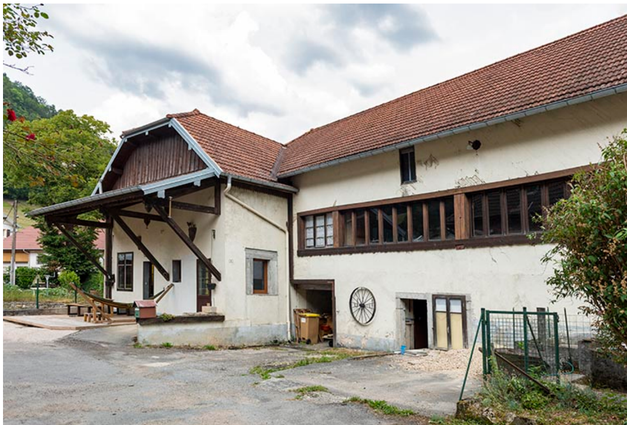
Forge : façade ouest (côté cour).
