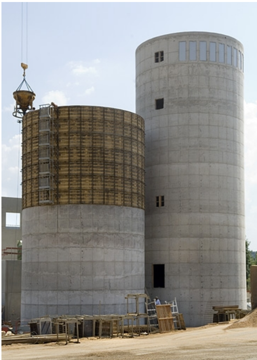
Chaudière et silos à sciure en construction.
