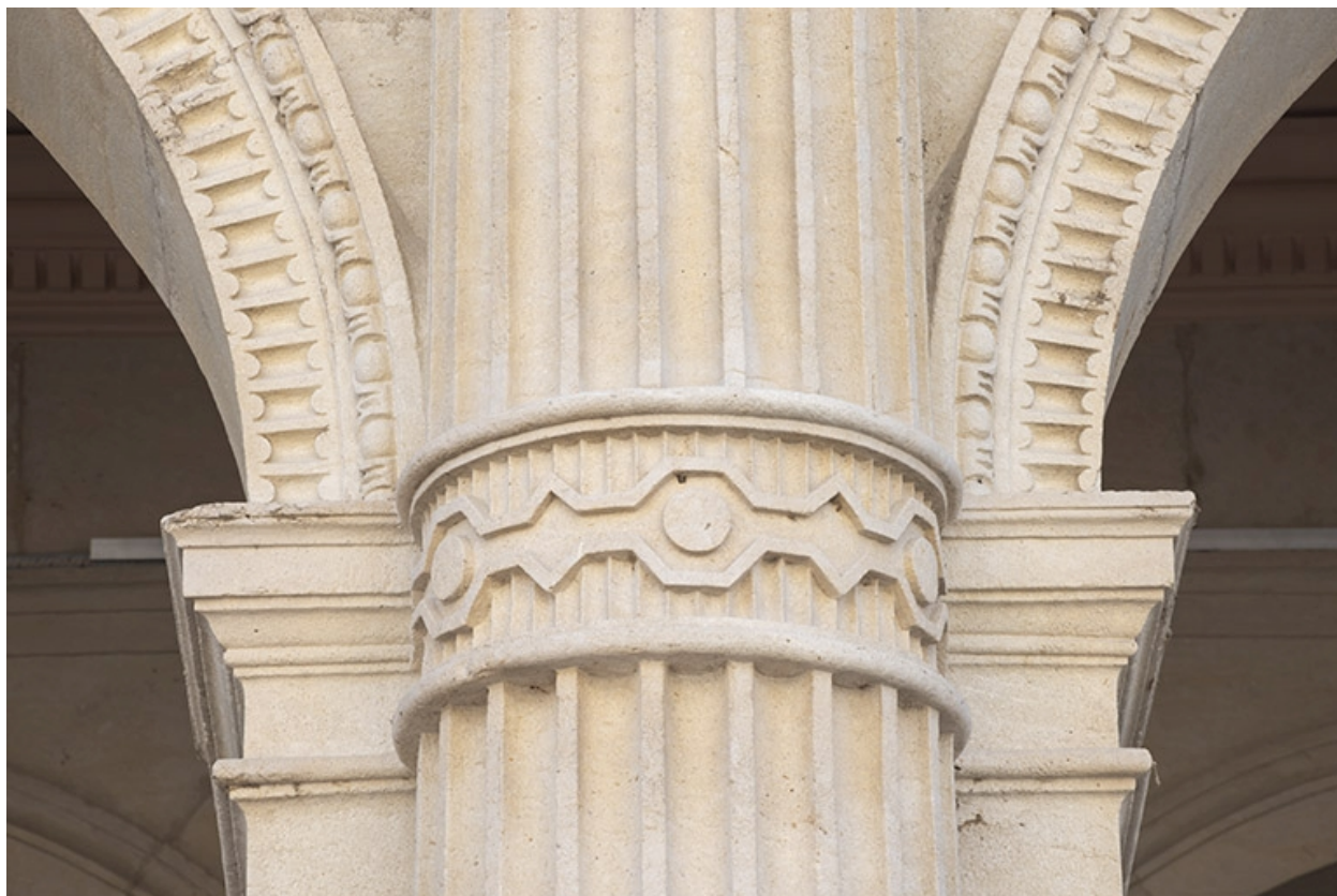
Façade antérieure, rez-de-chaussée : bague de colonne.
