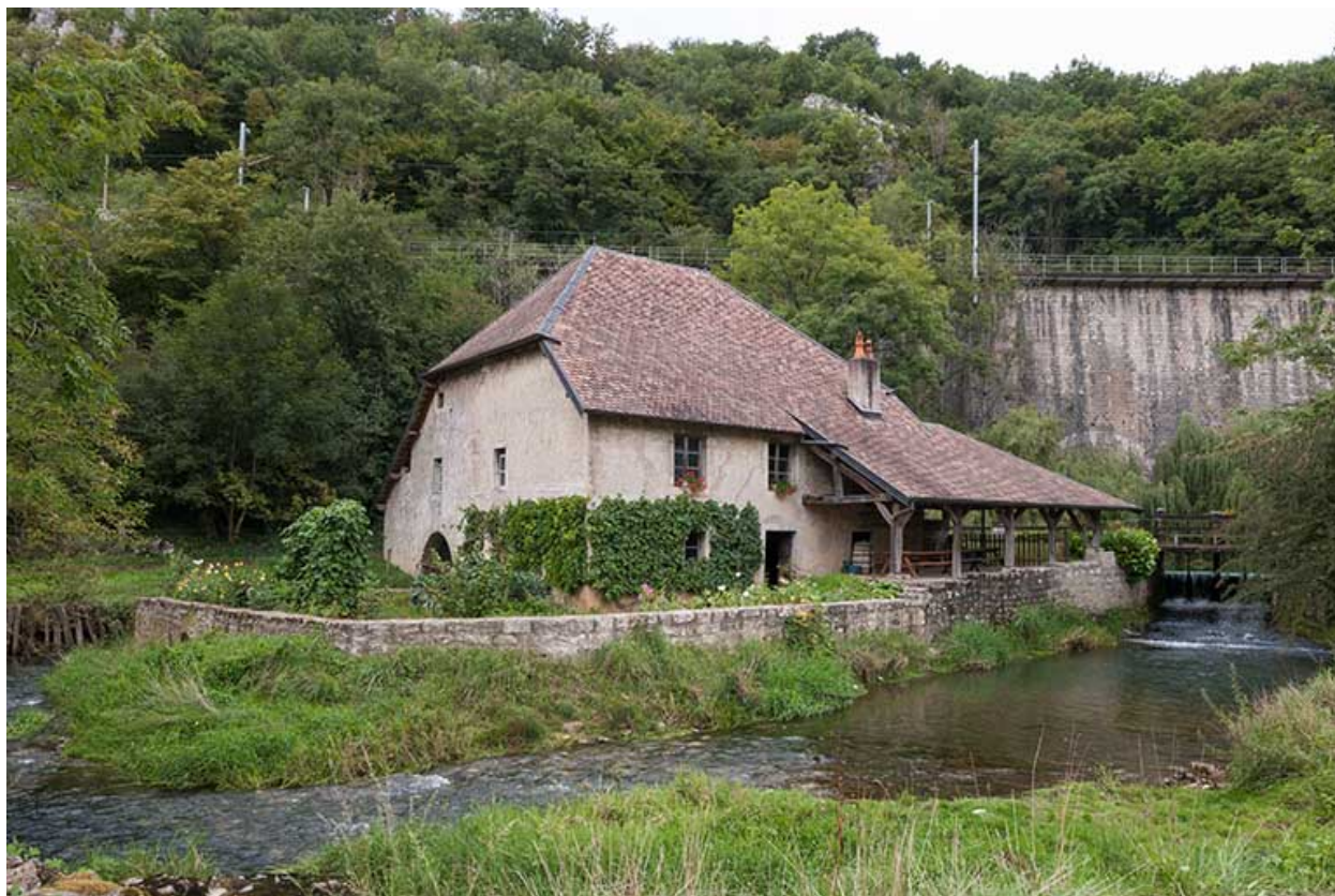
Vue rapprochée du moulin depuis le sud-ouest.
