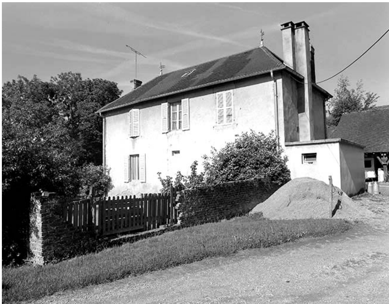
Façade postérieure du logement patronal.
