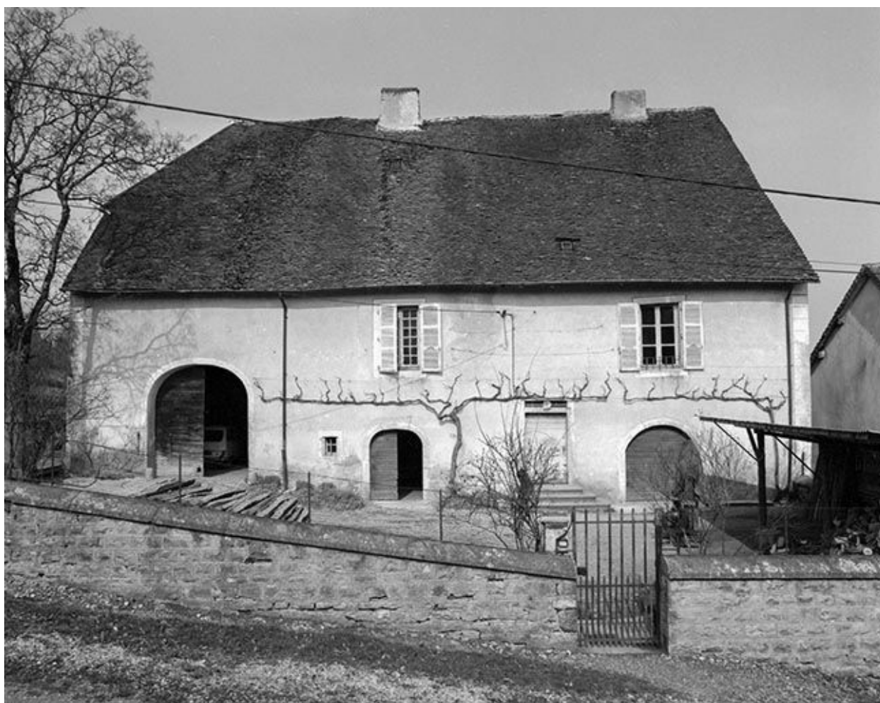
Façade antérieure, vue de face.
