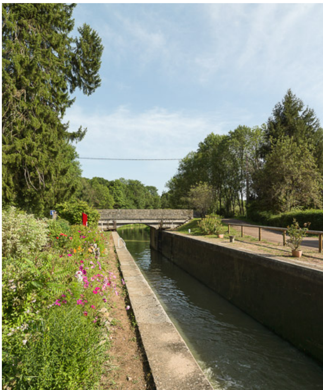
Vue du sas et du pont.
