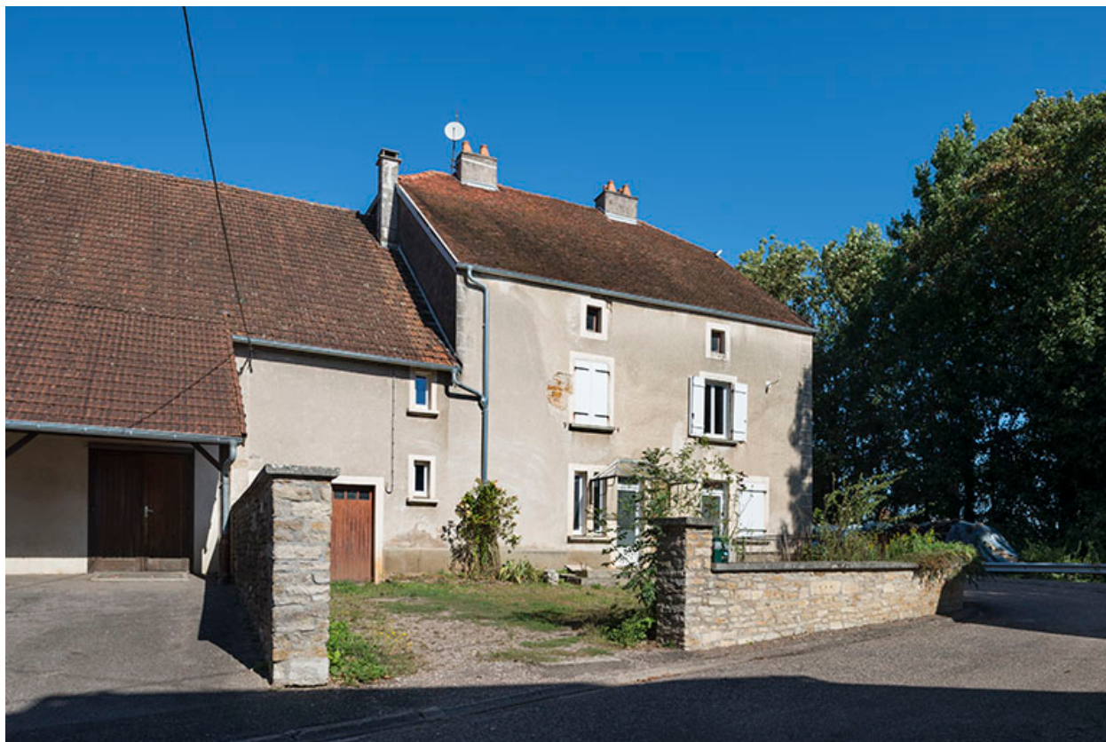
Vue depuis la rue de l'Eglise.
