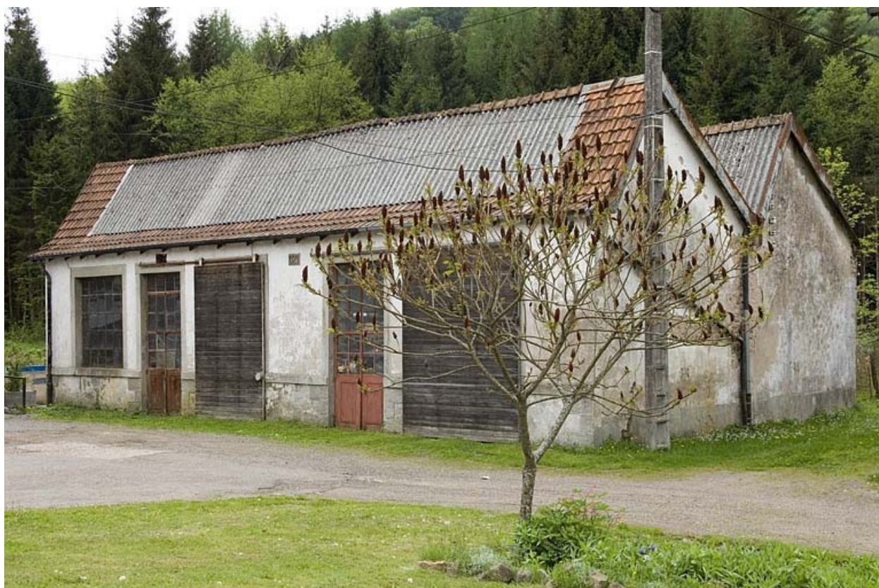
Atelier de réparation (menuiserie, forge).
