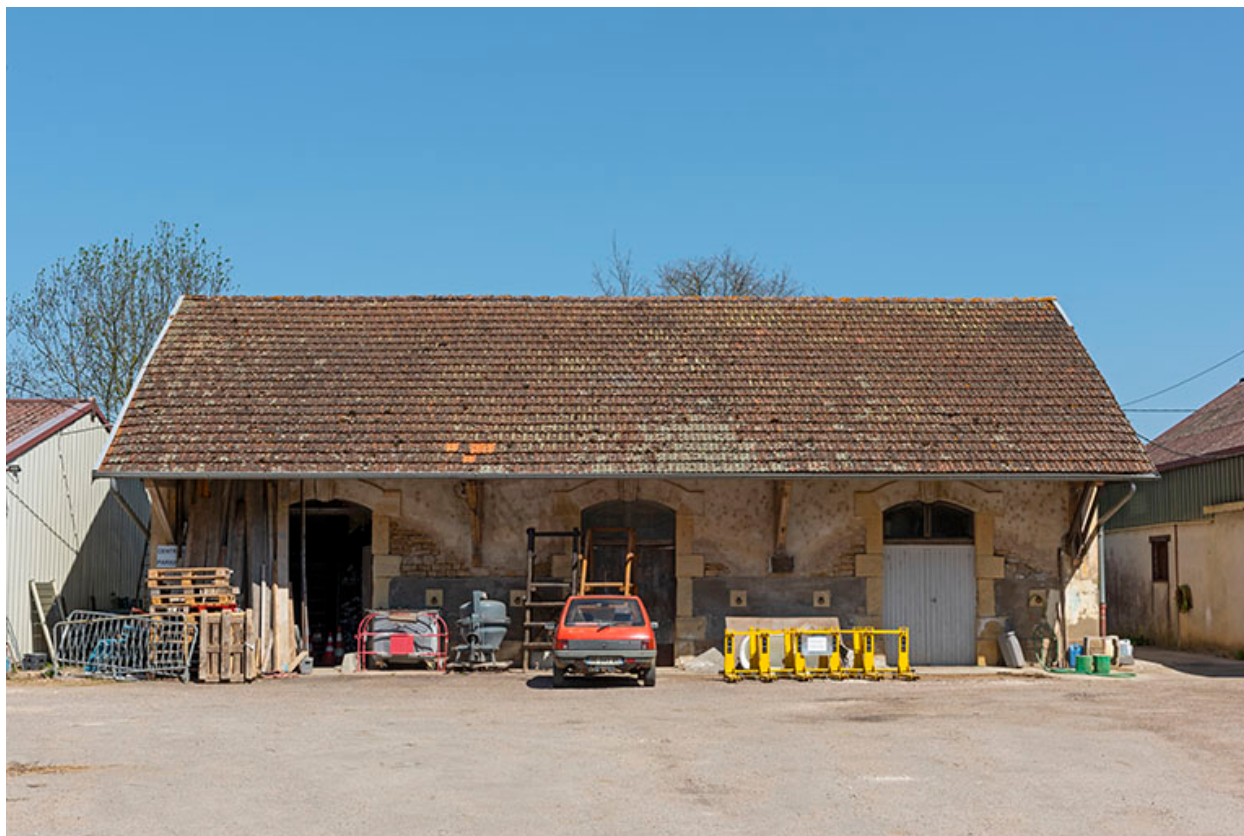
Le bâtiment central, de face.
