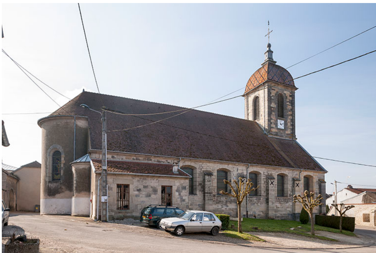
Vue de la façade nord.
