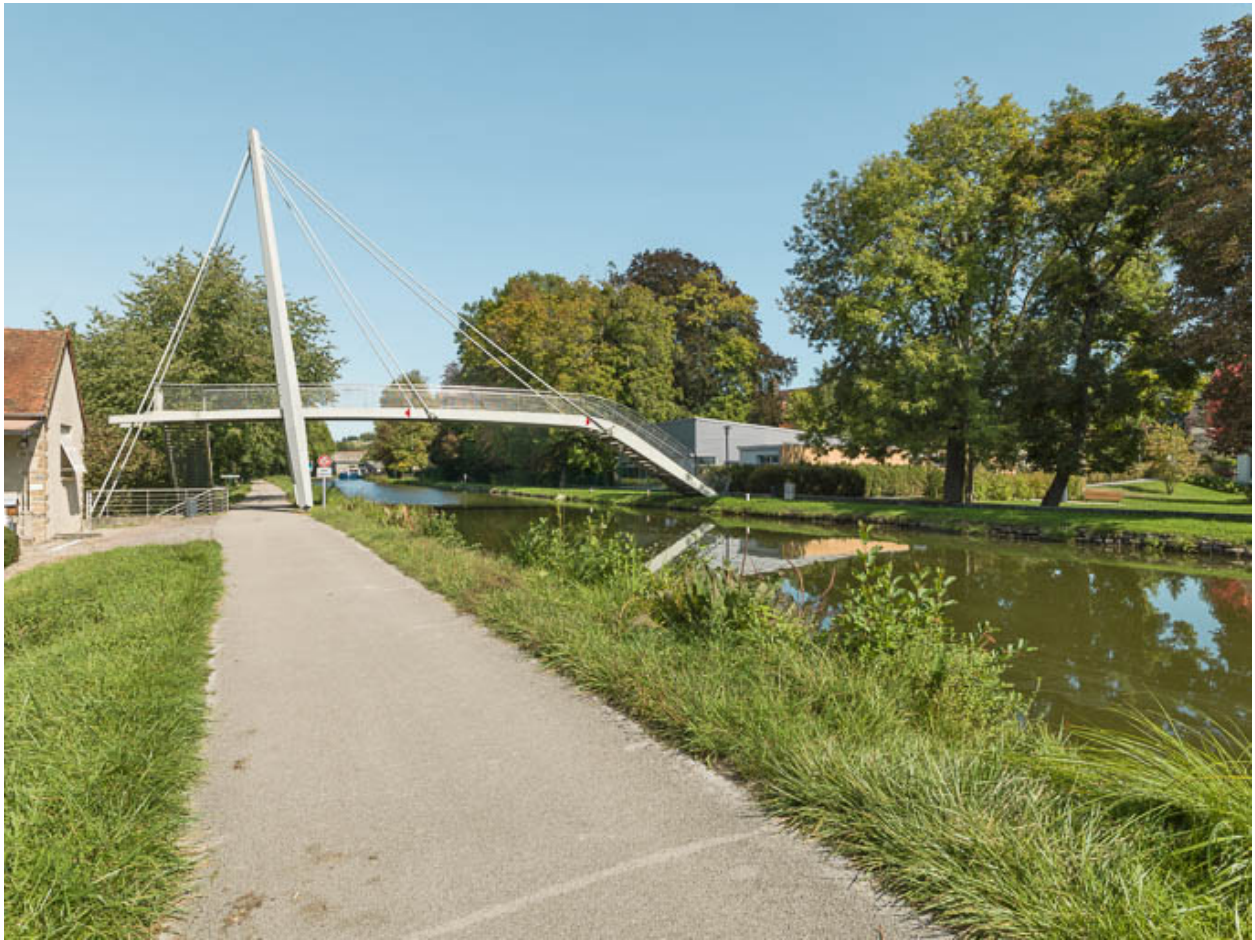
Vue d'ensemble de la passerelle.
