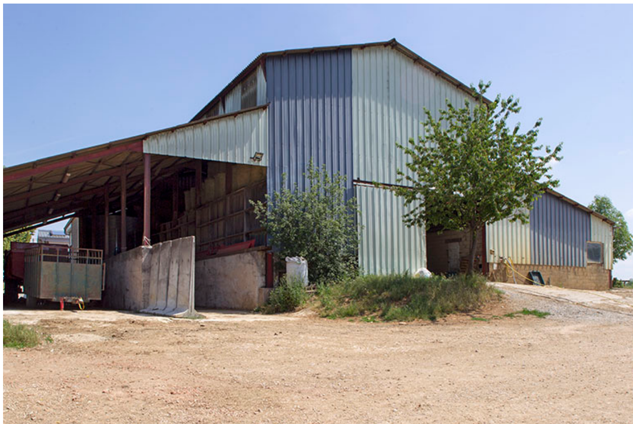
Pignon sud de l'entrepôt agricole.
