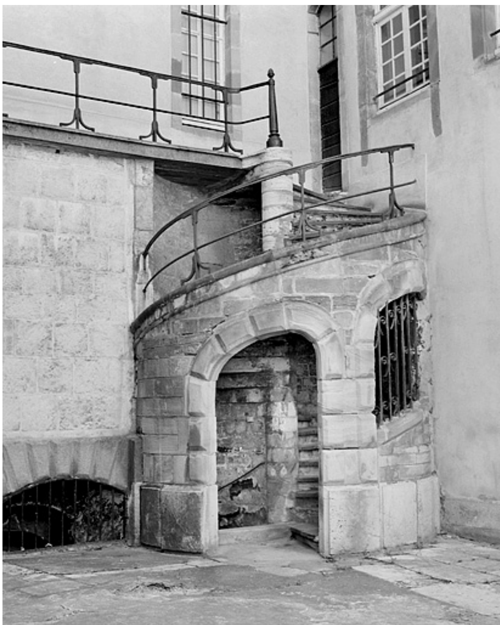
Cour de l'Ours. Escalier de la coursière.
