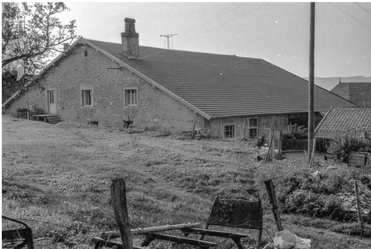
Ferme cadastrée 1945 D 180-181 : vue d'ensemble.
