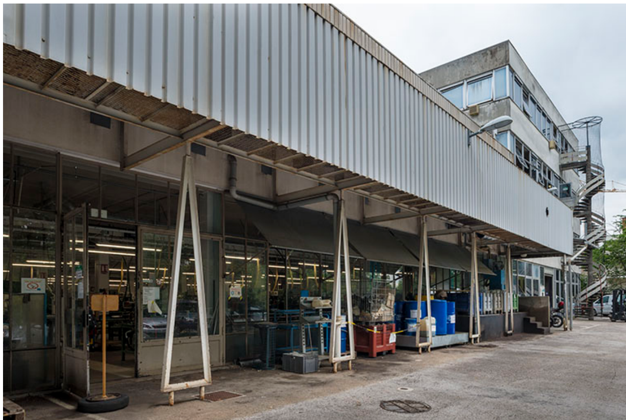
Usine B (12 rue du Tunnel). Façade est.
