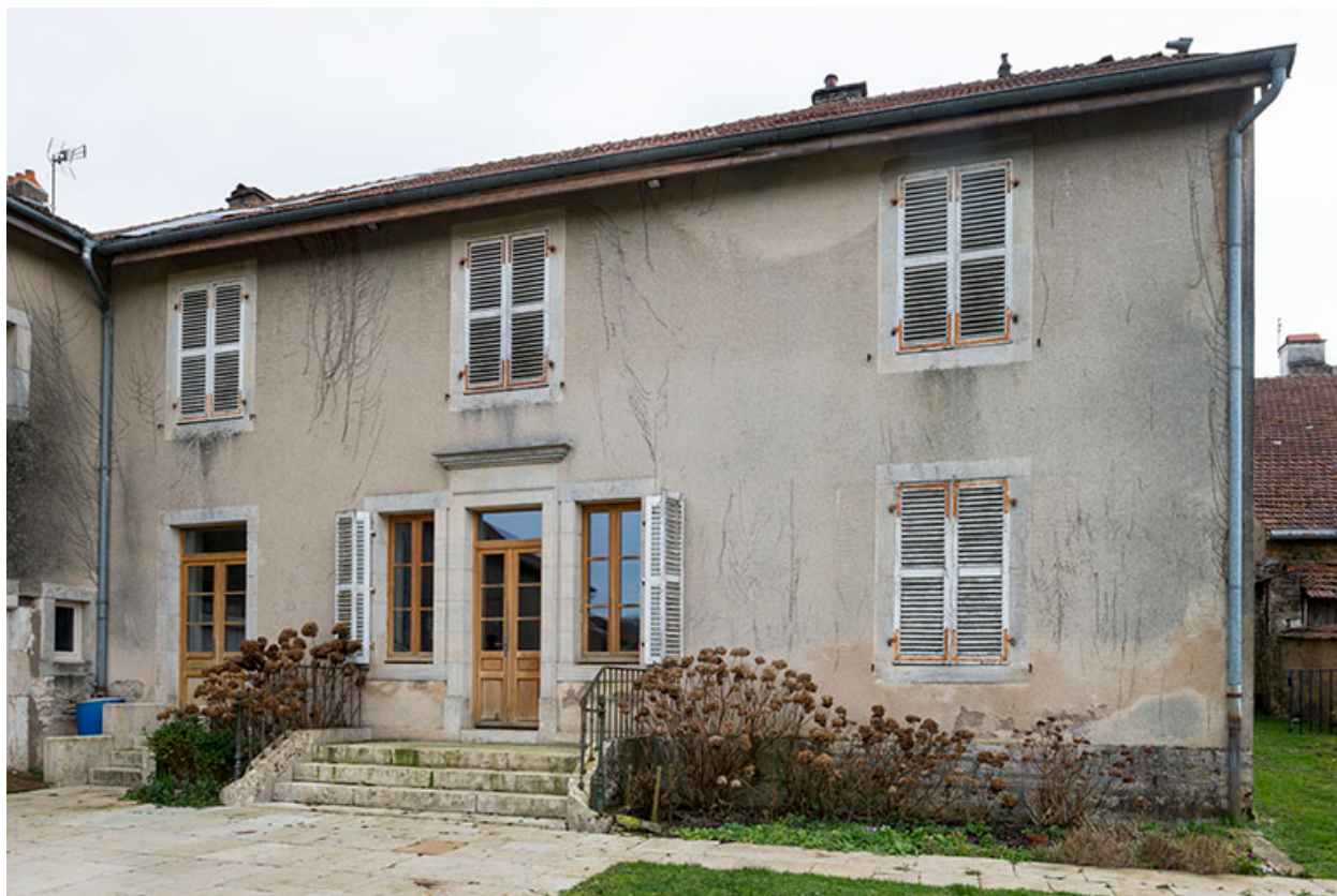
Façade postérieure, vue générale.
