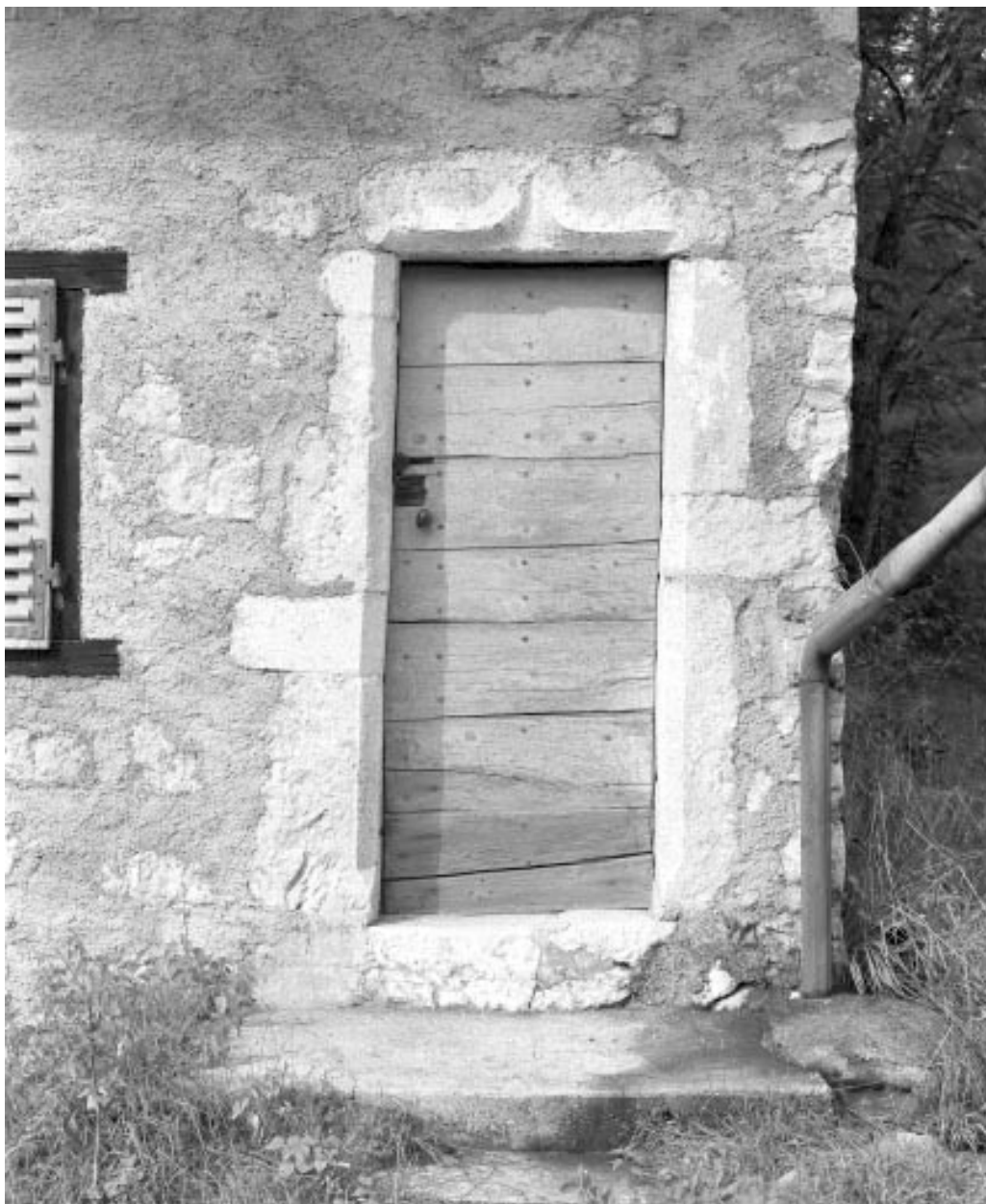
Porte d'accès au logis.
