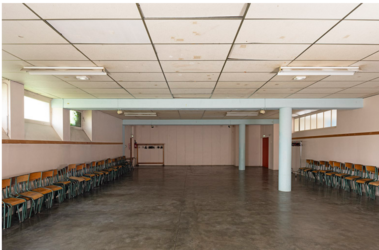
Etage de soubassement. Vue de la grande salle.
