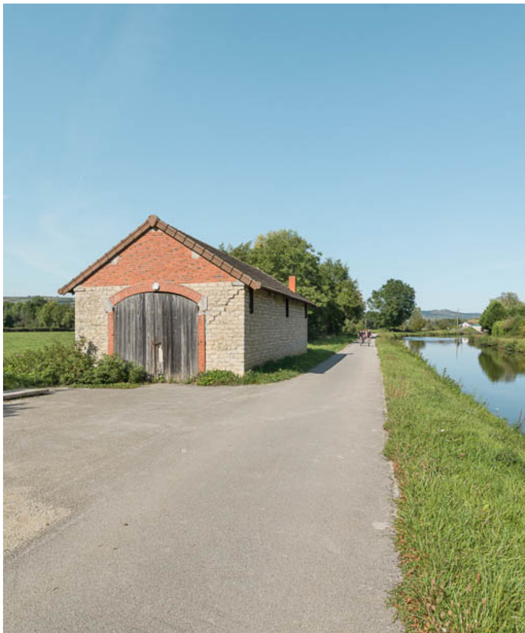
Vue d'ensemble de la remise, rive gauche.
