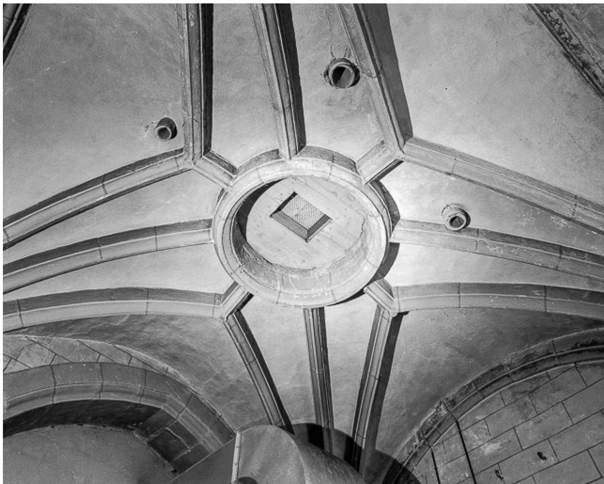
Détail de la voûte.
