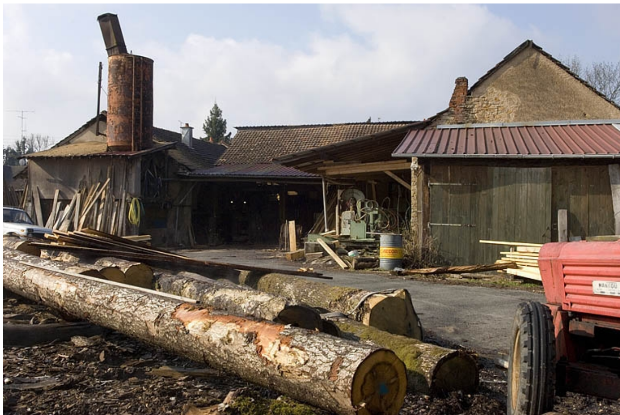
Façade postérieure de l'atelier de scierie.
