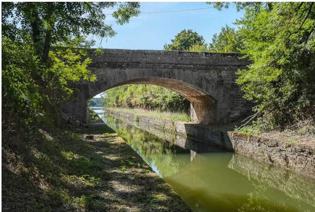
Vue du pont depuis l'amont.
