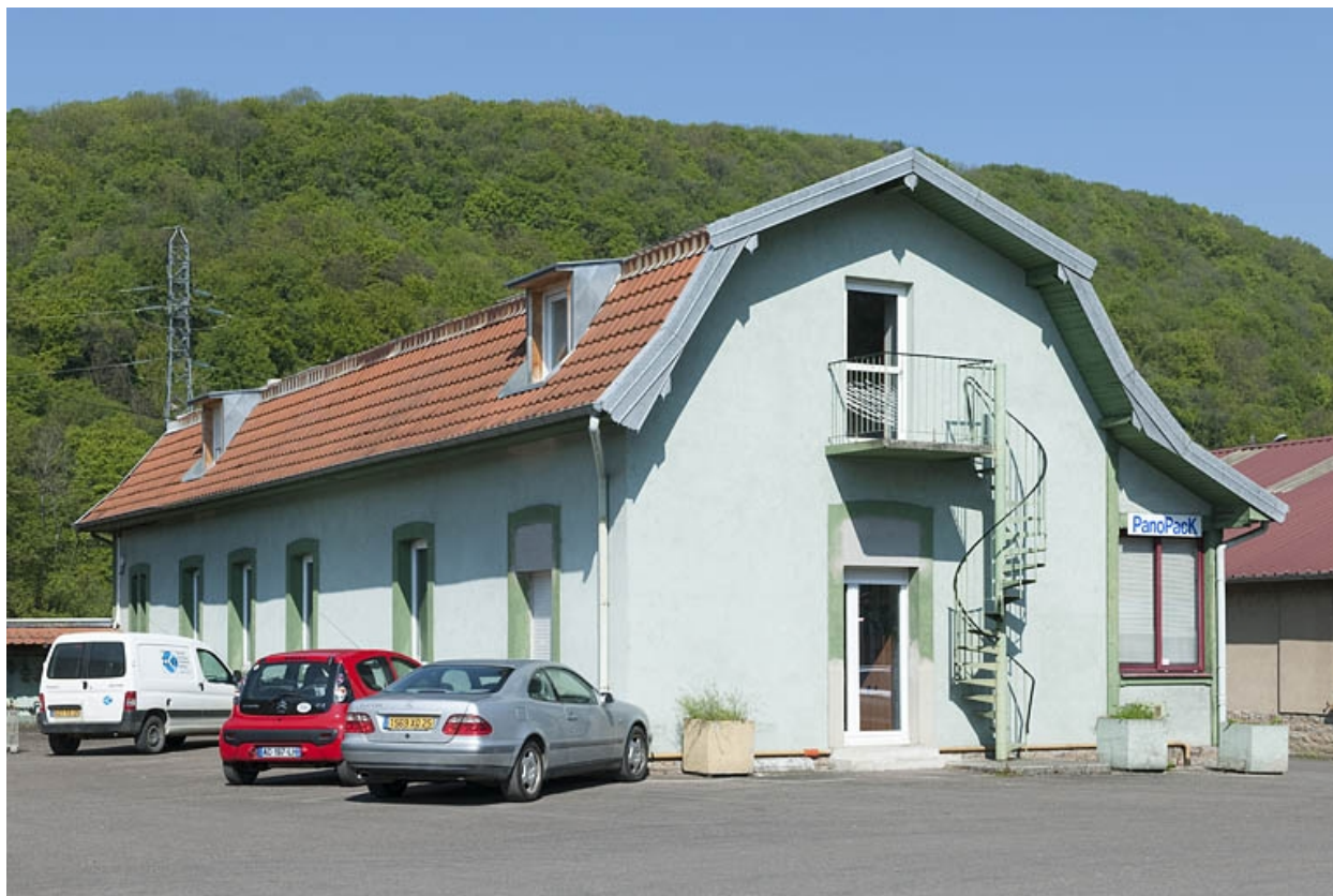
Bureaux. Vue depuis le sud-est.
