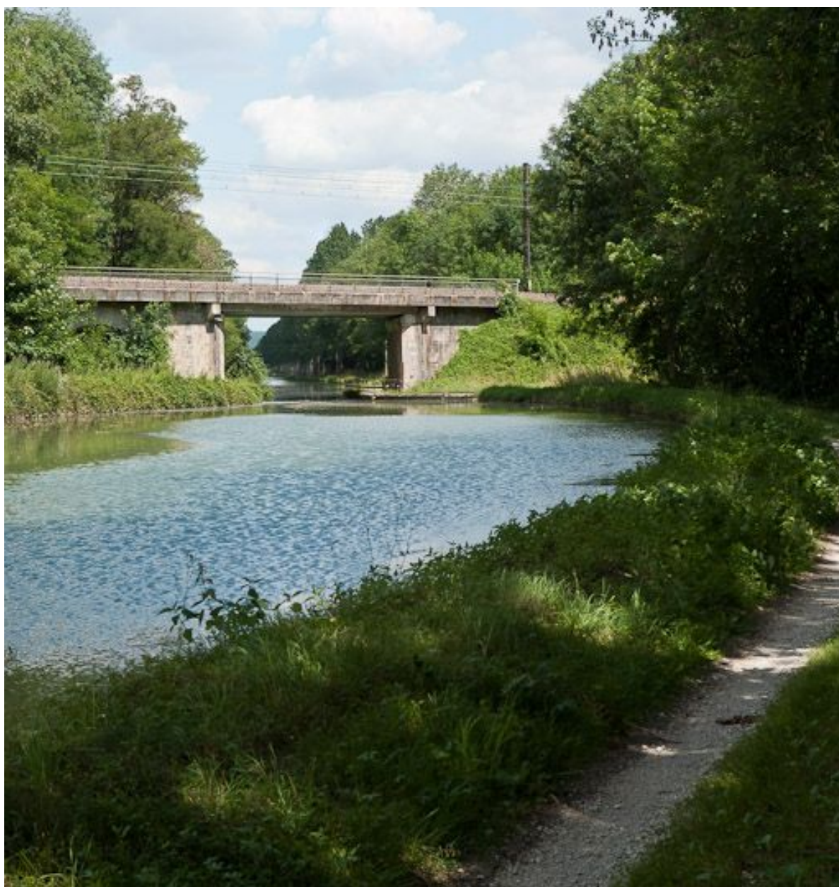
Vue du pont.
