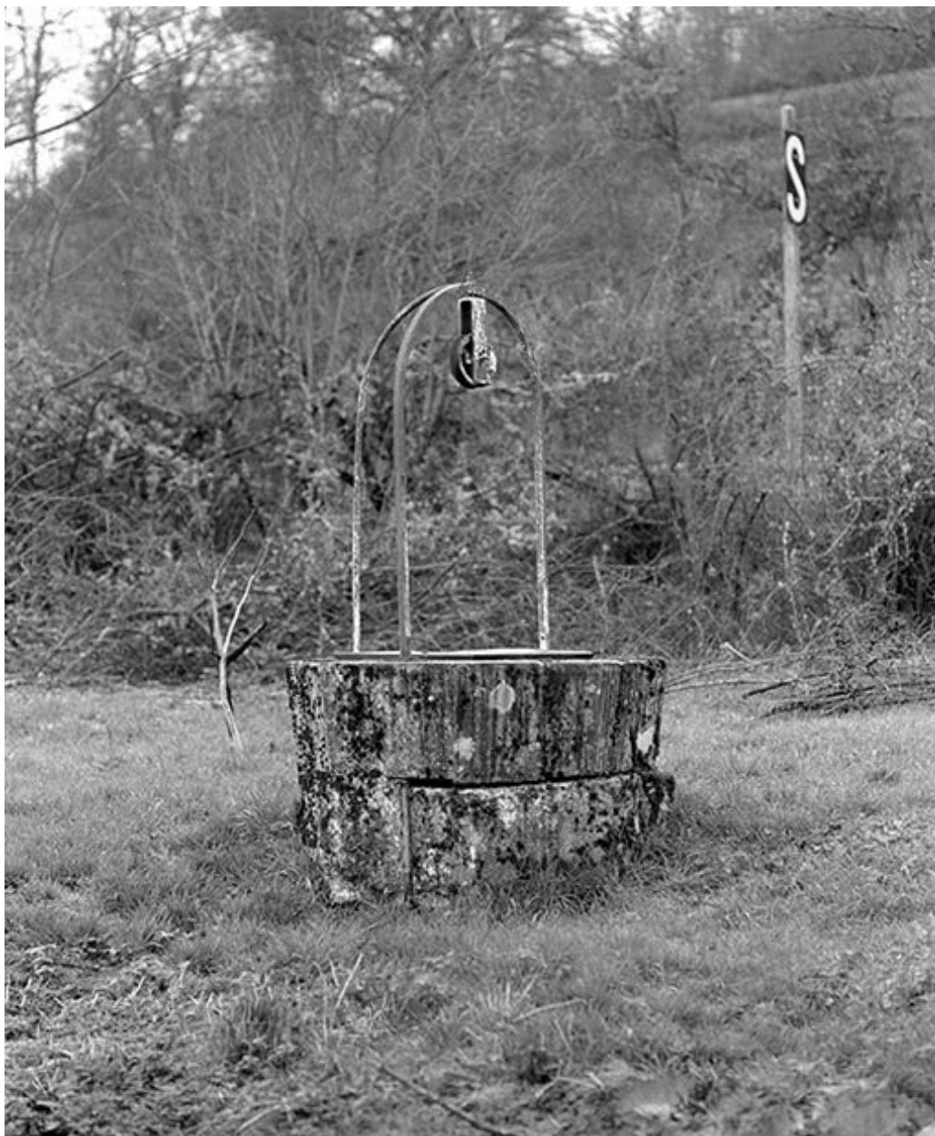
Détail du puits de maison d'éclusier.
