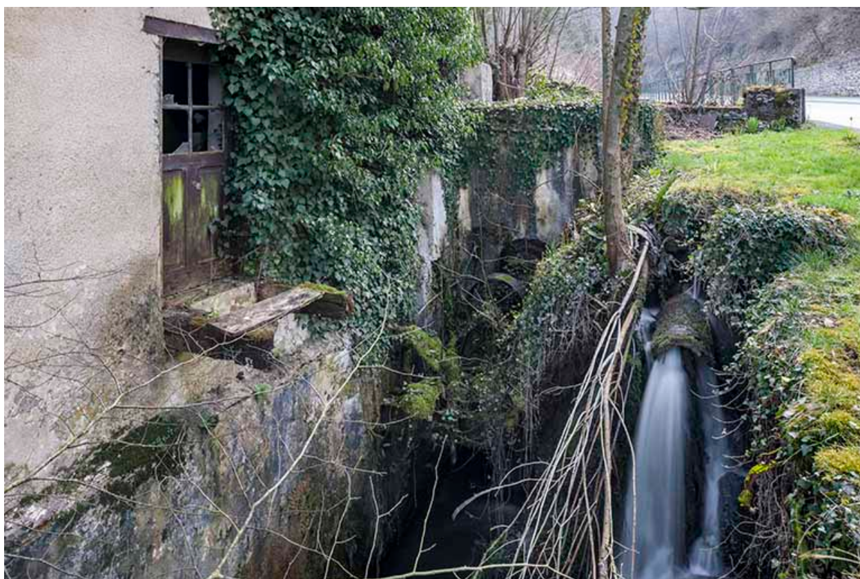
Canal d'amenée et vestiges de la turbine.
