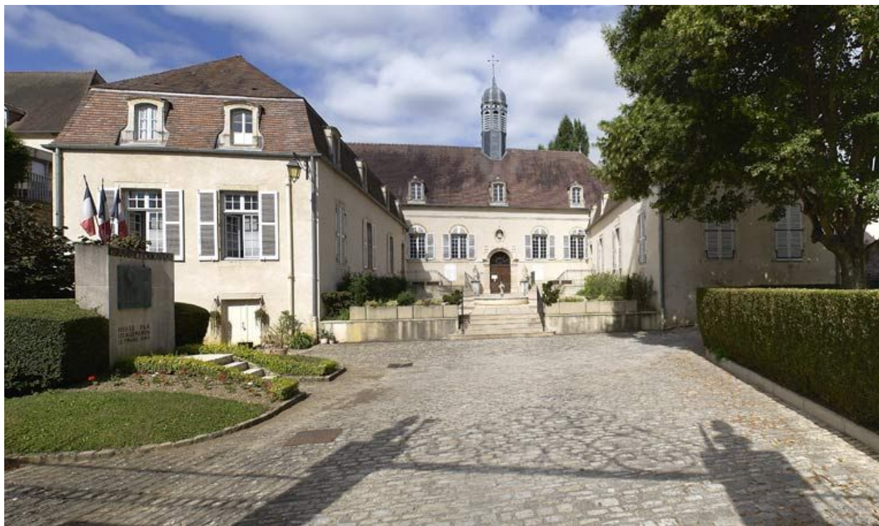
Façade principale depuis le portail.
