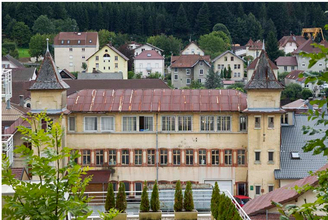
Usine : façade postérieure, vue en plongée.
