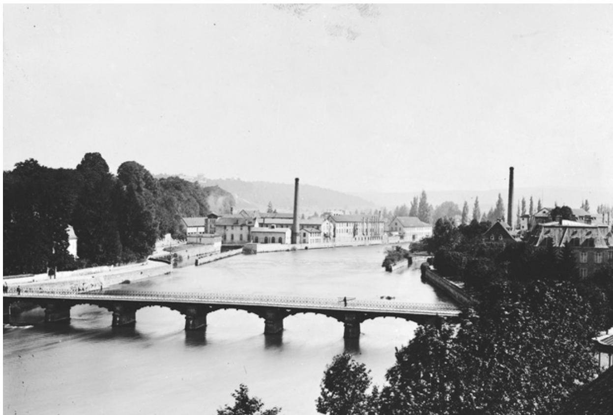
Usine Sous-Roches depuis la rive droite. Photogr. [cliché inversé], s.d. [1914].
