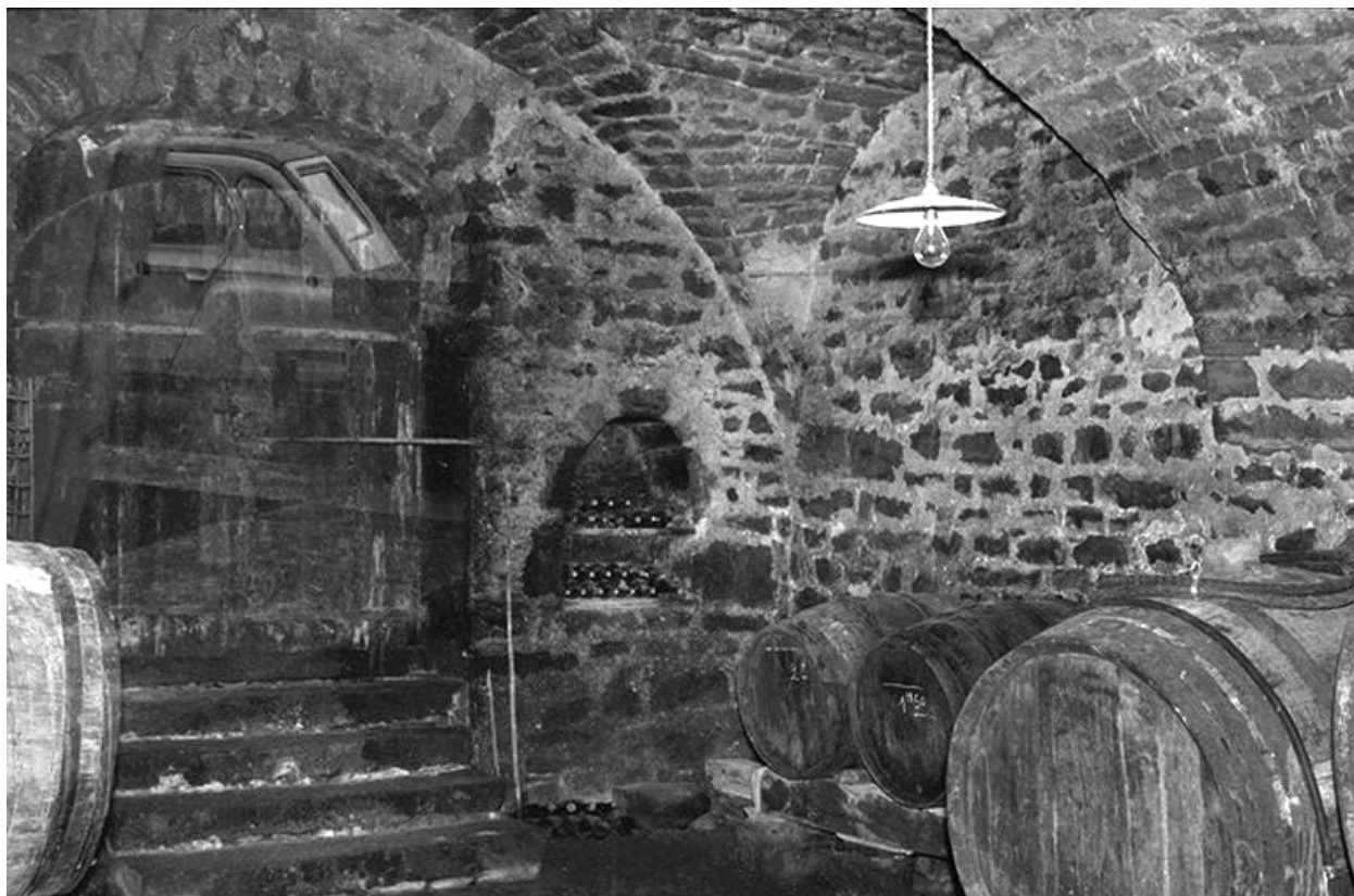
Ferme cadastrée 1965 AD : la cave
