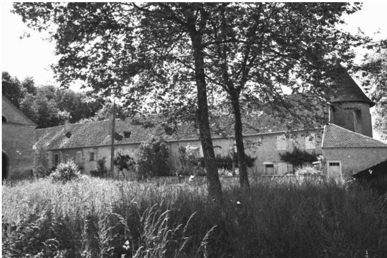
Vue d'ensemble du logement ouvrier en 1981.
