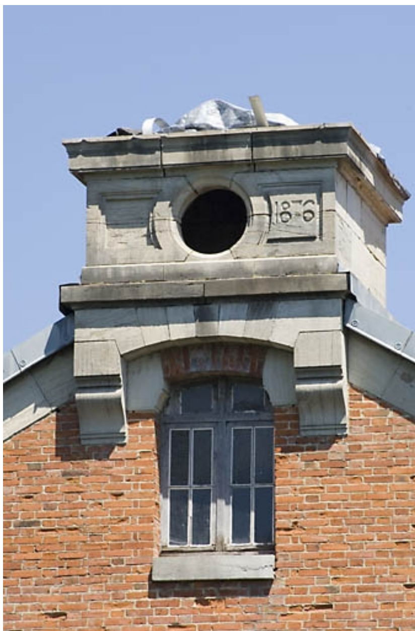
Couronnement de façade sud du bâtiment d'eau.
