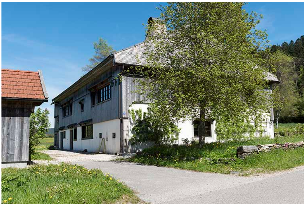
Façades nord et ouest.
