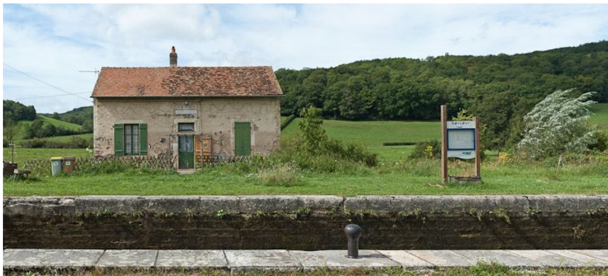
Vue de face de la maison éclusière.
