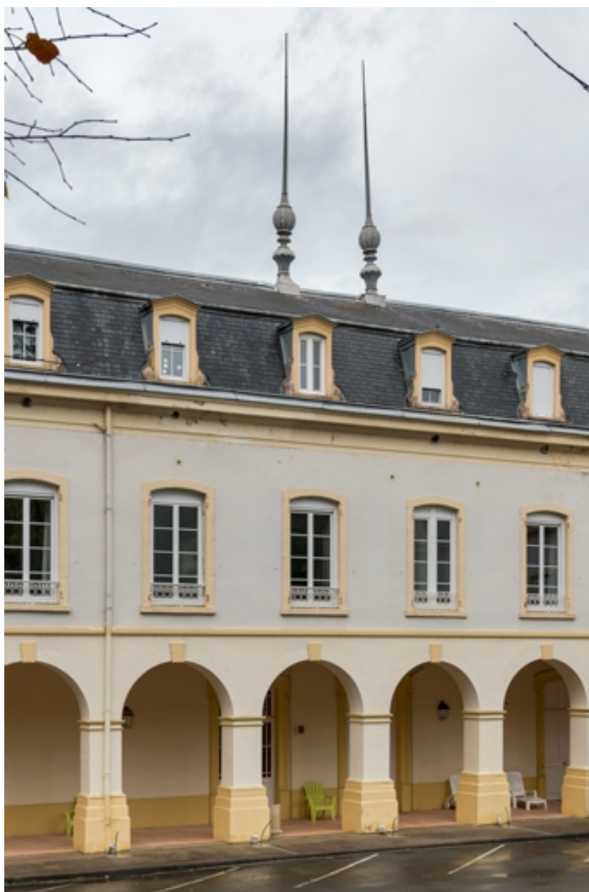
Cour, détail de l'aile nord.
