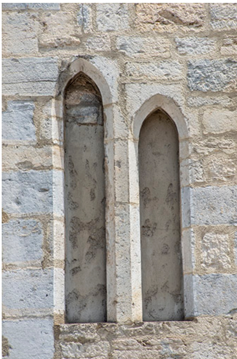
Façade antérieure. Baies étroites du deuxième étage.
