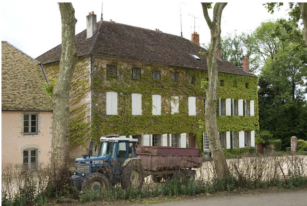
Logement patronal vu de trois quarts.
