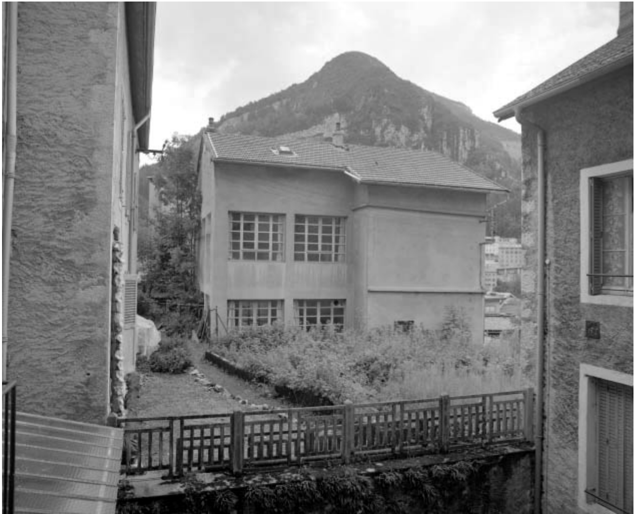
Façade postérieure du premier atelier.
