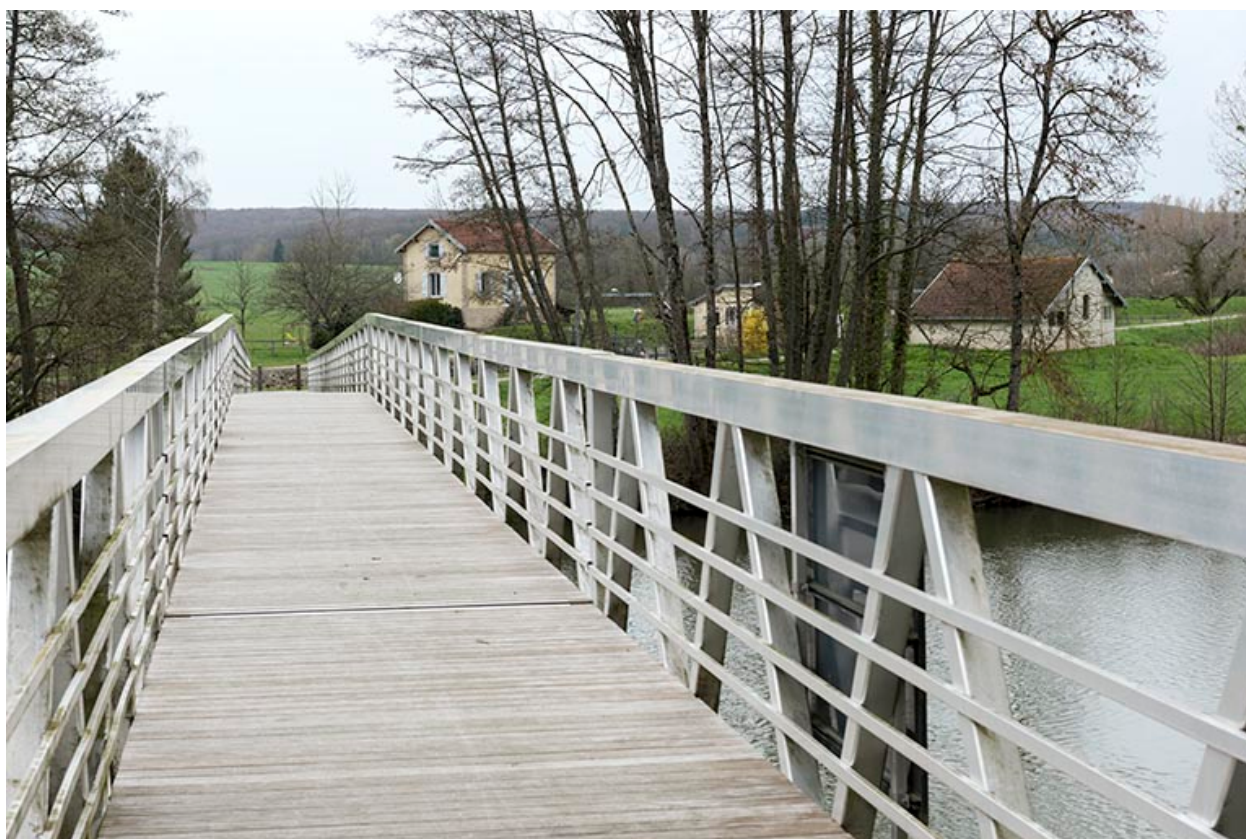
Passerelle enjambant la Saône. Vue de dessus.
