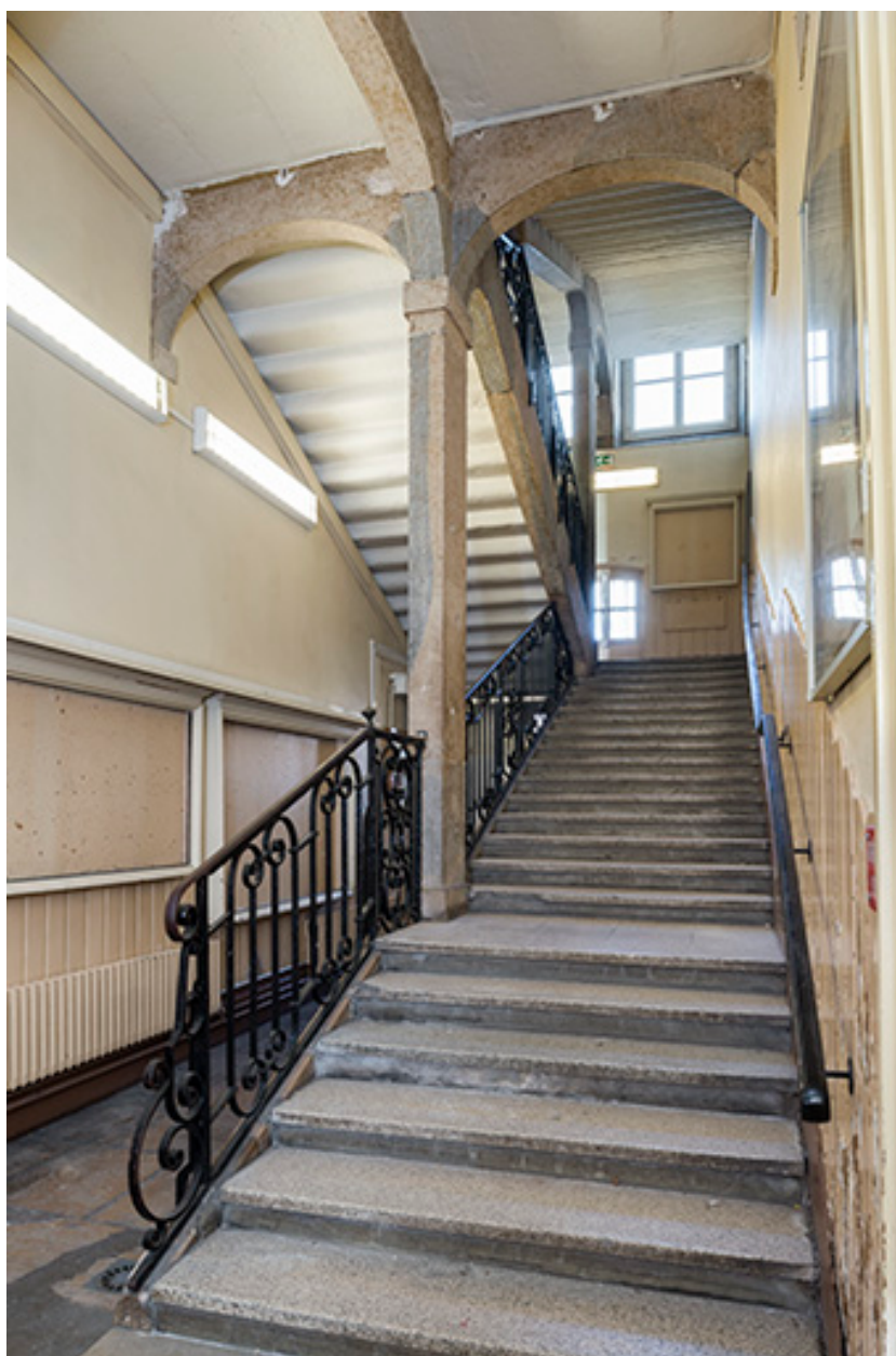
Grand escalier : vue d'ensemble au rez-de chaussée.
