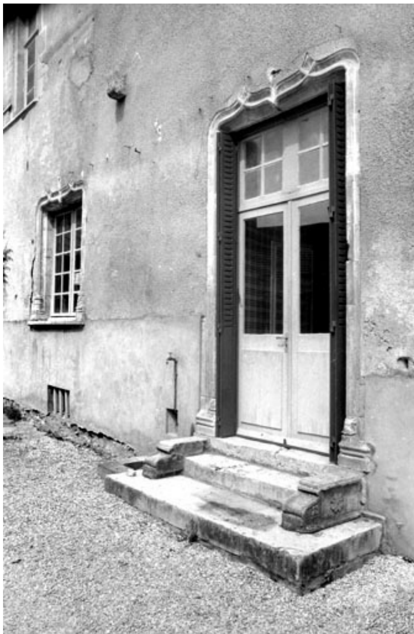
Maison du prieur : détail de la porte d'entrée.
