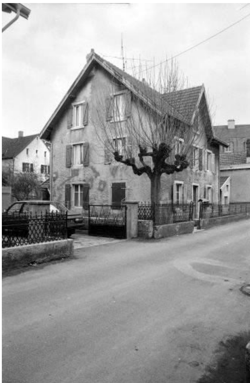
Audincourt : maison située 2 rue de la Musique.
