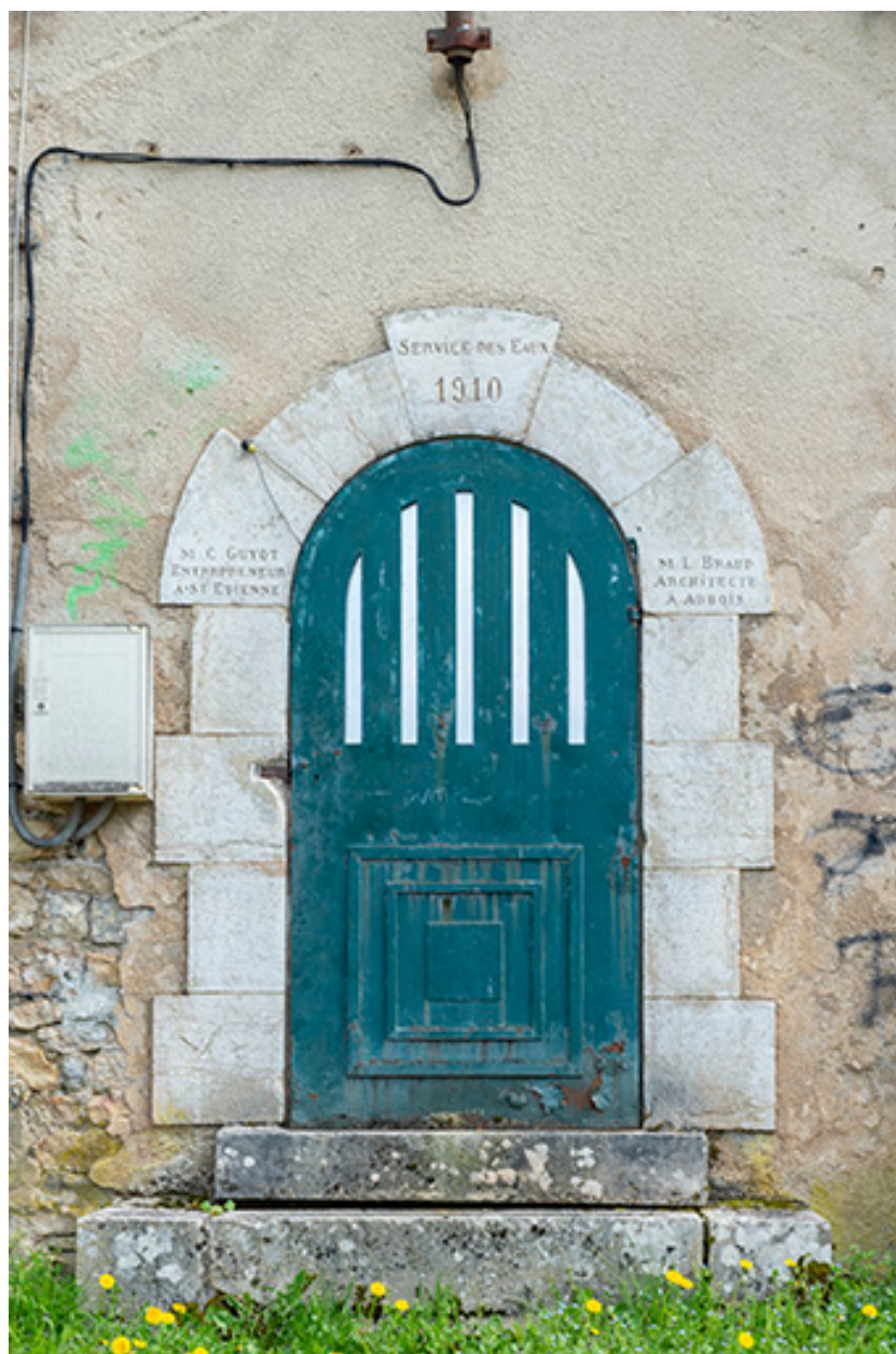
Réservoir de Chambenoz, 1910. Porte du réservoir.
