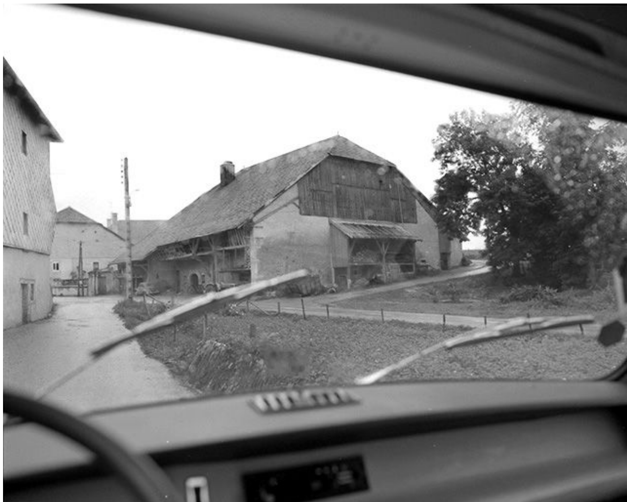
Façades postérieure et latérale droite.
