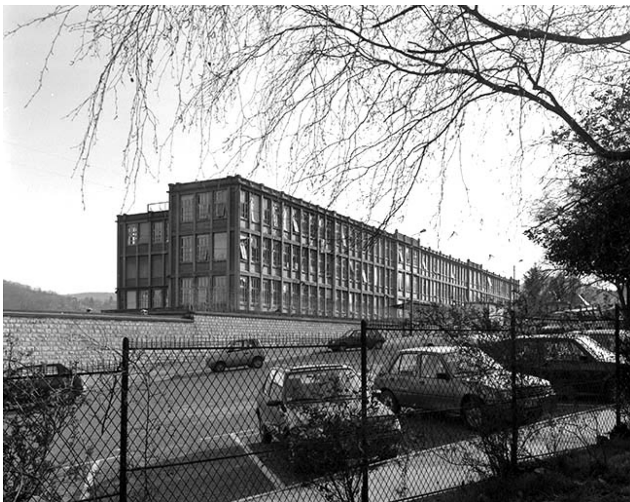
Façade antérieure et façade latérale gauche.
