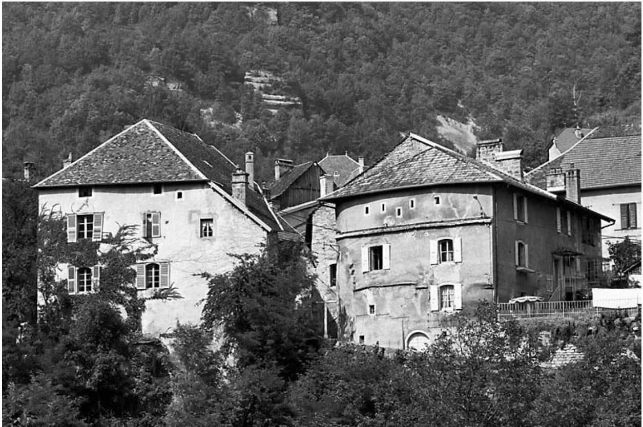
Elévation depuis le sud.
