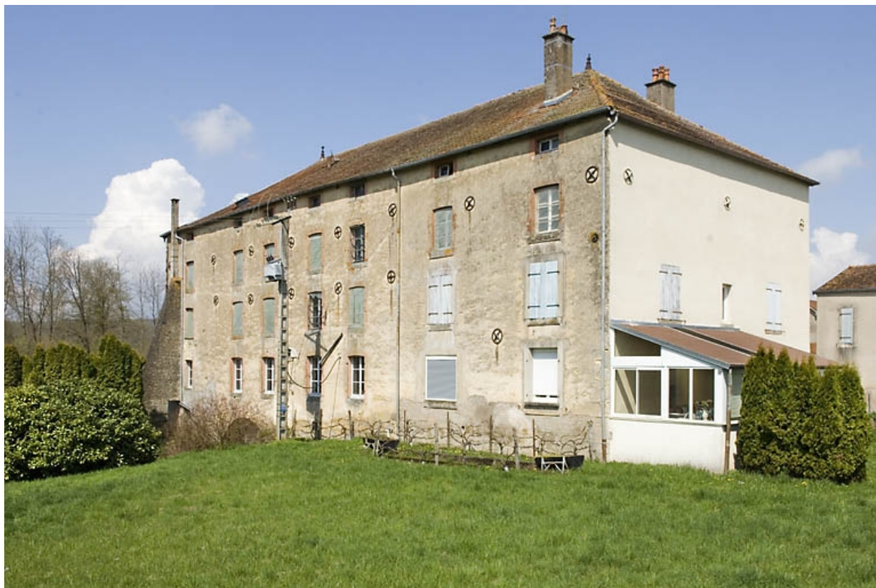
Façade postérieure vue de trois quarts arrière.
