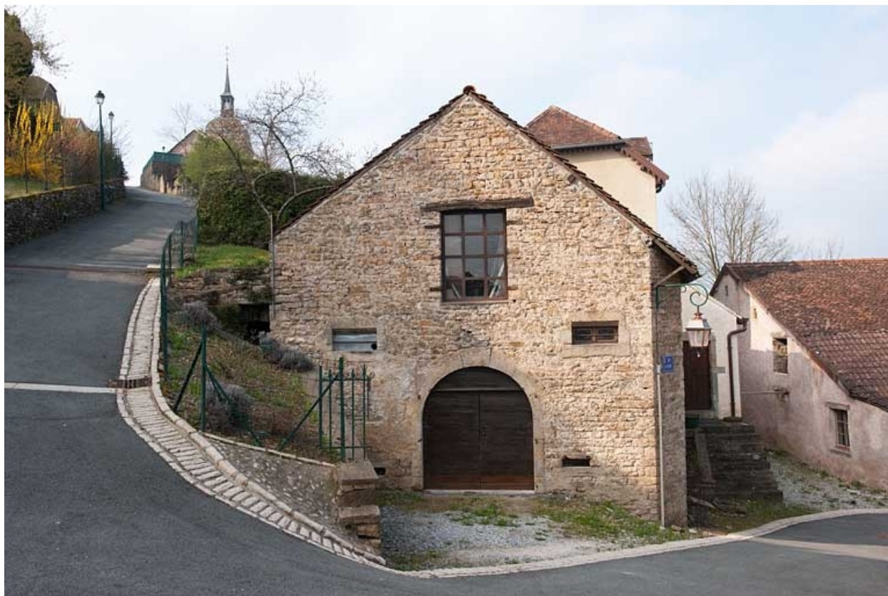
Grange : façade latérale gauche.
